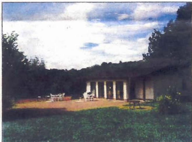
Die herrlich gelegene Anlage des OTC mit vier Sandplätzen und einem geräumigen Clubhaus befinden sich am Ende der Ziegeleistraße im Osterseifen. (M/R-Bild)
